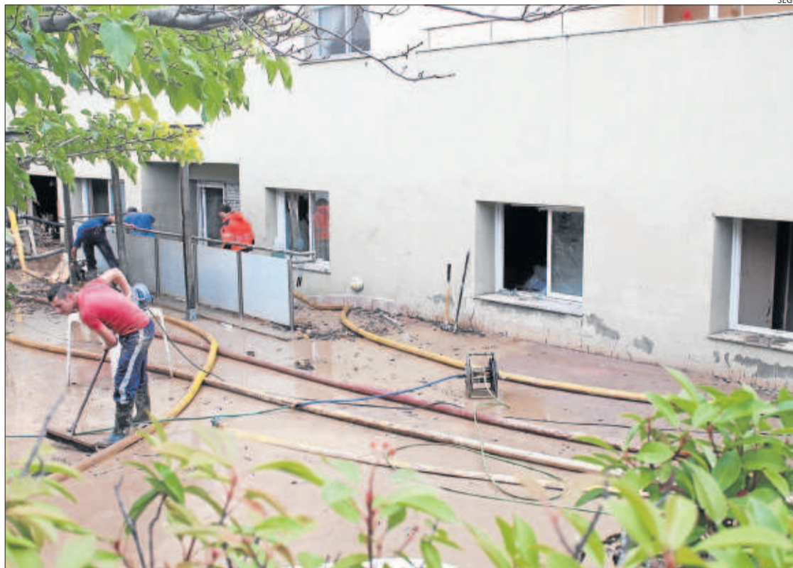
Estado del patio de la residencia tras la riada. A la derecha las ventanas de las habitaciones.
